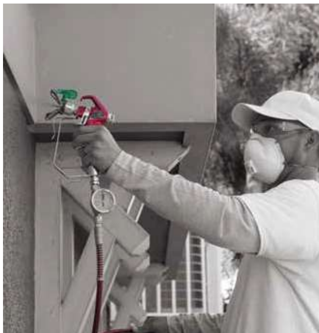
Peinture émulsion latex à travers une buse standard 517 à 70 bars
